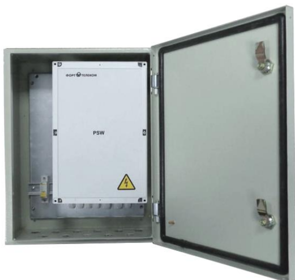
Рисунок 7.3 - Монтаж коммутатора в уличном шкафу.
