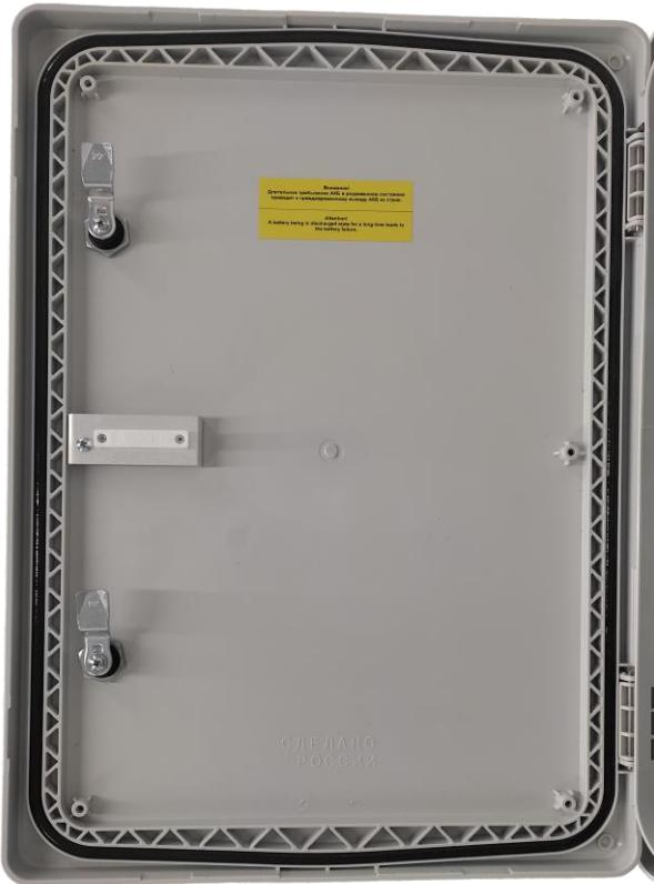
Рисунок 3.6.1 - Датчик вскрытия на крышке коммутатора
