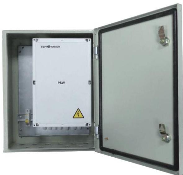
Рисунок 7.3 - Монтаж коммутатора в уличном шкафу.
